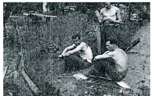
Die beiden Bilder zeigen Arbeiten beim Bau einer Wasserleitung, die noch in Holzrohren geführt wurde und worüber sich der Fotograf, ein amerikanischer Besatzungssoldat, sehr verwundert zeigte.
