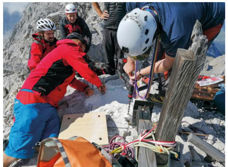
Bohrarbeiten für die Fixierung der Grundplatte
