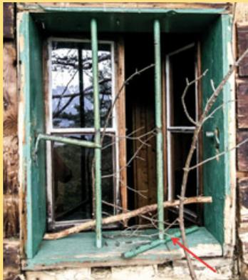
Der offensichtlich mittels Säge durchtrennte Mittelsteg der massiven Fenstervergitterung ist ersichtlich.
